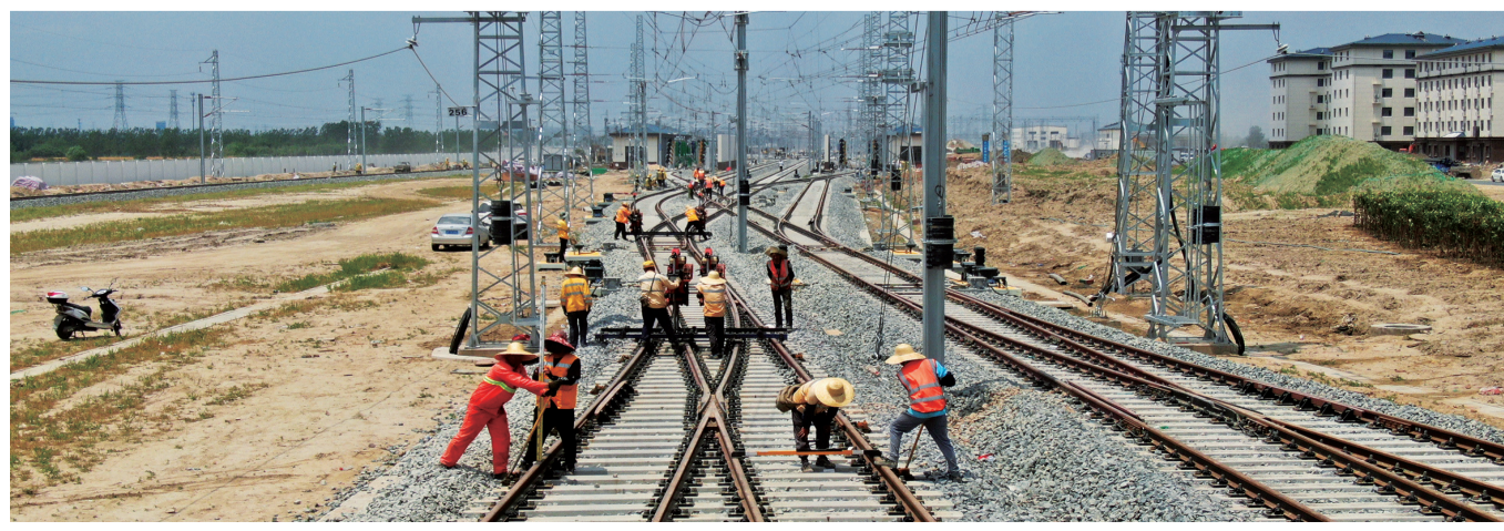
昨天，施工人员在动车所检查调整线路几何状态。当日，南通动车所进入静态验收阶段，待静态验收、动态验收后，这个江苏省第四个高铁动车所将与通沪铁路同步开通运营。节后复工以来，2000名建设者奋战在存车线、检修库等项目工地上，抢回了因疫情影响的工期，保质保量完成了建设任务。 记者 许丛军摄
