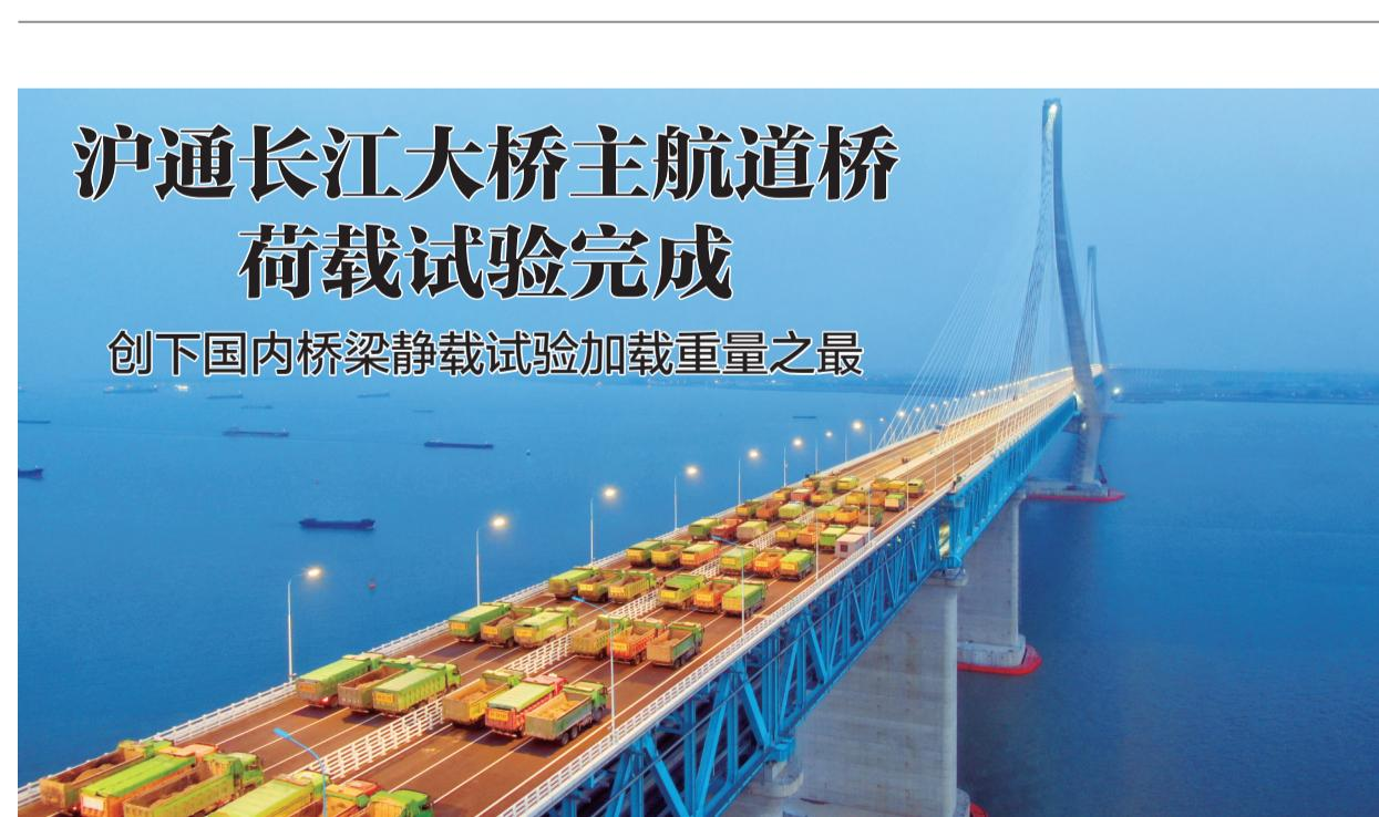
本报讯 (记者彭军君 通讯员简珍珍)28日凌晨3时许，在经过两个夜间通宵辛苦作业后，由中铁大桥院集团设计、中铁大桥局集团施工的世界最大跨度公铁两用斜拉桥沪通长江大桥主航道桥，顺利完成通车前的“大考”荷载试验，中铁桥隧技术有限公司承担了本次荷载试验工作，加载总重量近9000吨。此重量为目前
