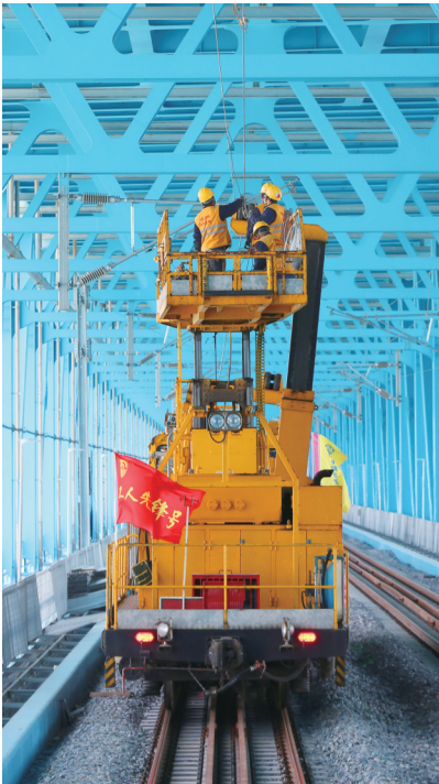
2020年3月中旬，中铁电气化局施工人员在沪苏通长江公铁大桥进行接触网导线架设。 记者 许丛军摄
