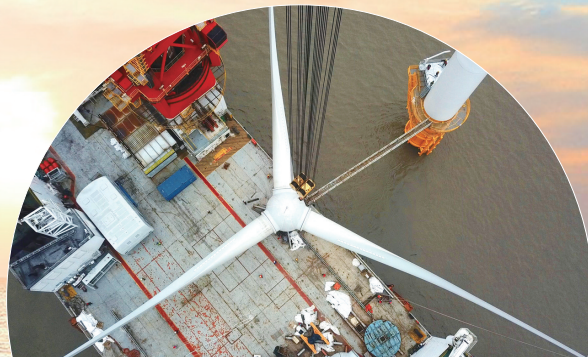
▲盛东海上风电 场吊装风机叶片
