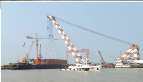
▲2015年3月28日海巡06910维护沪苏通长江公铁大桥4#墩围堰吊装
