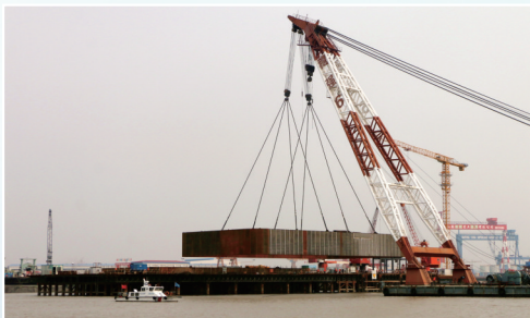
▲2014年11月12日沪苏通长江公铁大桥3号墩钢沉井吊装
