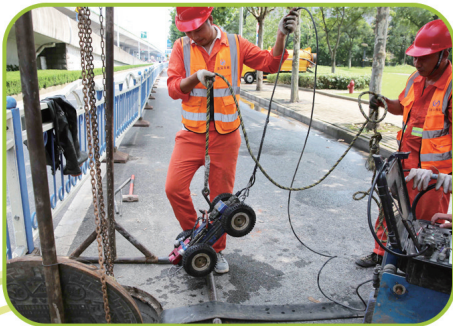
应用现代科技手段检测雨污水管网。 记者 尤炼摄
