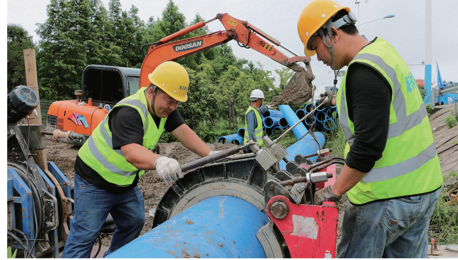
昨天,在如东至海安清水连通工程现场,海安水务职工正在加快推进管线定向导向、热熔对接管道等工序。
