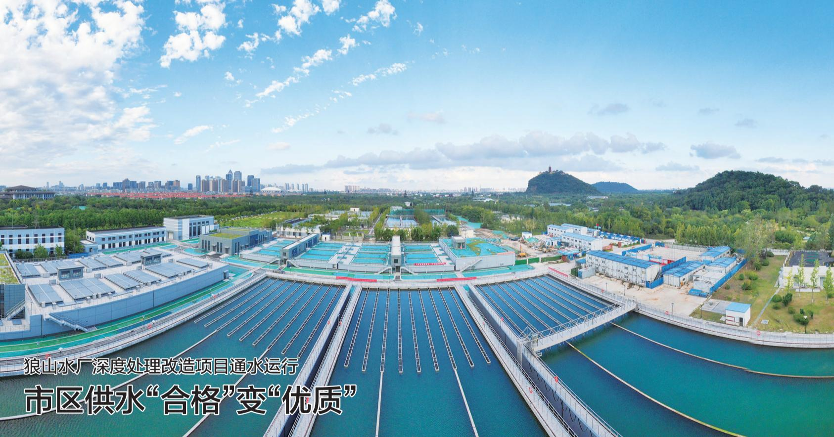
昨天，南通狼山水厂60万立方米/日深度处理改造项目正式通水运行，标志着南通市区及区域供水实现深度处理全覆盖，全面实现从供“合格水”向供“优质水”的转变。狼山水厂深度处理工程总投资5.2亿，采用了臭氧-活性炭处理工艺，能进一步去除水中有机物和微生物，有效降低水中氨氮等的含量，经过深度处理后的水质将优于国家标准。目前，南通市区有崇海、洪港、狼山三大主力水厂，总供水能力200万立方米/日，负责南通市区及通州、海门、如东、启东区域供水，服务人口500多万人。图为昨天拍摄的狼山水厂平流沉淀池。
