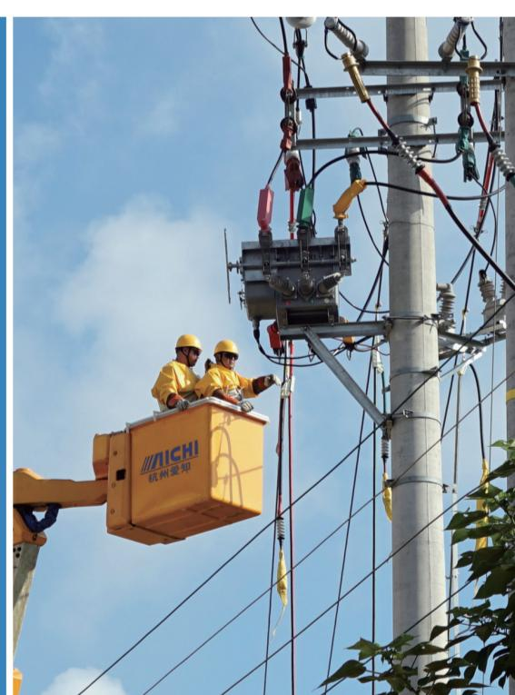
日前，海门10千伏厂洪线44号杆进行拔杆作业，带电作业人员与一台带电作业机器人一起，通过人机配合，成功完成了当天的带电作业任务。据悉，这是南通地区首次将机器人应用到高空带电作业上。
