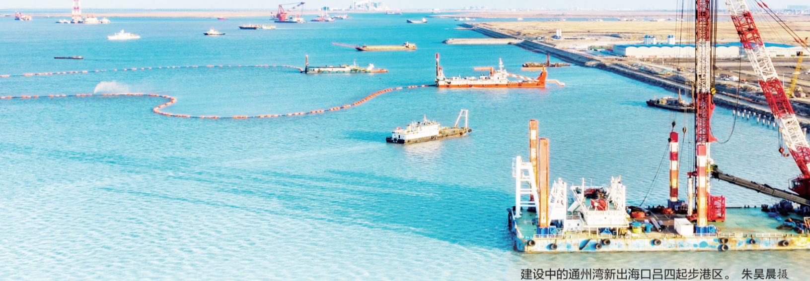
建设中的通州湾新出口吕四起步港区。朱晨晨摄
