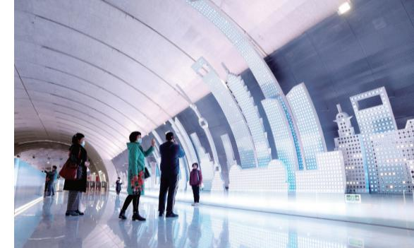
9日,市民游客在上海地铁15号线吴中路站站厅内拍照。上海地铁15号线吴中路站站厅采用净跨达到21.6米的预制大跨叠合拱形结构,是上海地铁首个无柱大空间站台大厅,带给乘客一种广阔的空间感,也成为市民游客眼中最美地铁站和网红打卡点。新华社照片
