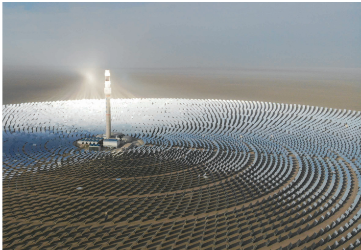
24日拍摄的敦煌100兆瓦熔盐塔式光热电站。
