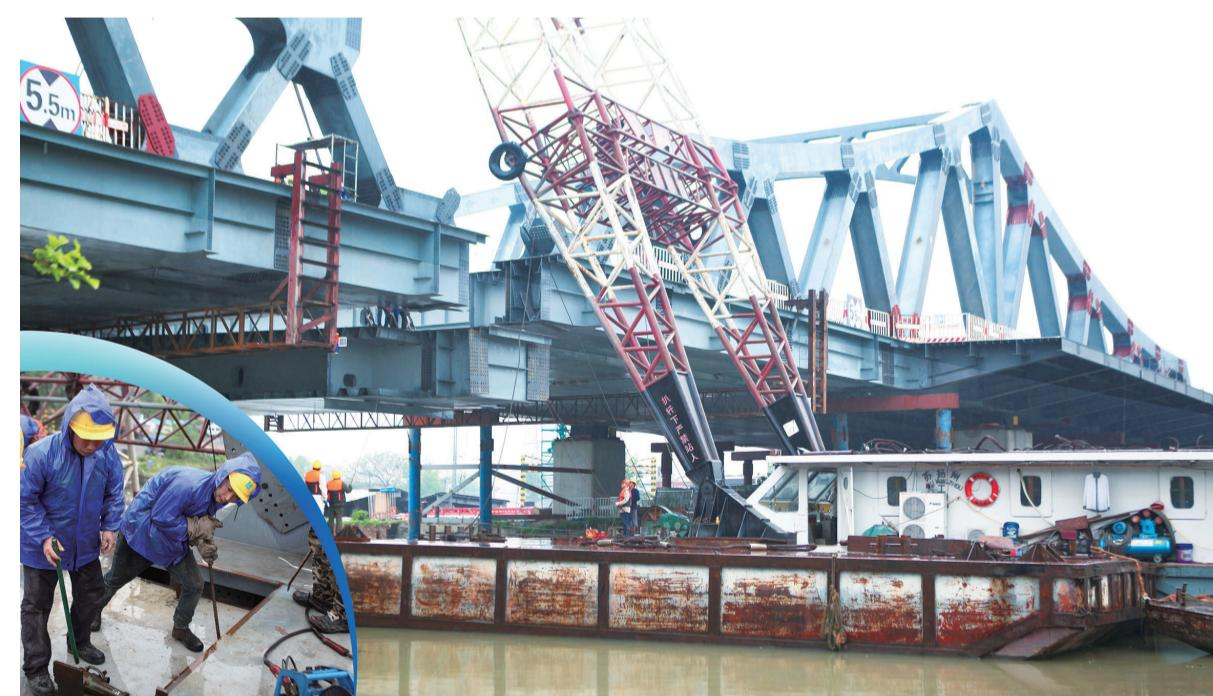
27日上午，港平路通扬运河大桥顺利合龙，该桥承载着高铁新城的大跨越，此次合龙标志着该大桥主体结构已基本完工，实现了节点目标。
