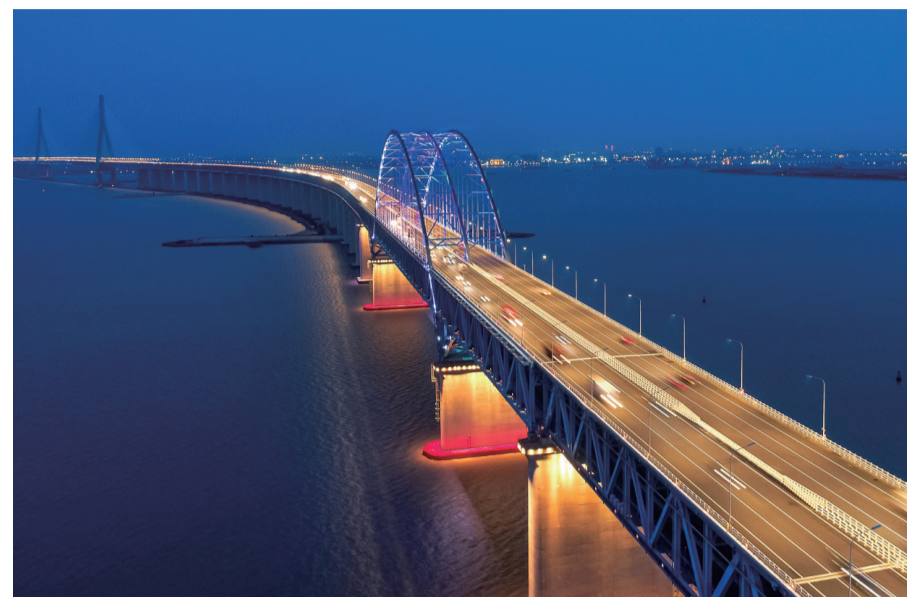
沪苏通长江公铁大桥夜色 周建国摄
