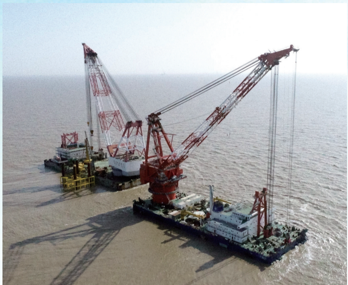
海上风电施工现场
