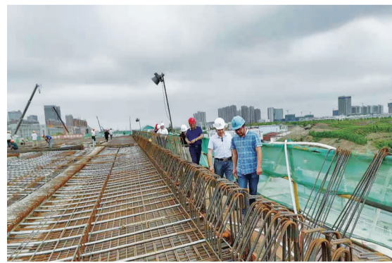
高架桥上部箱梁钢筋骨架制作。 记者 蒋娇娇摄
