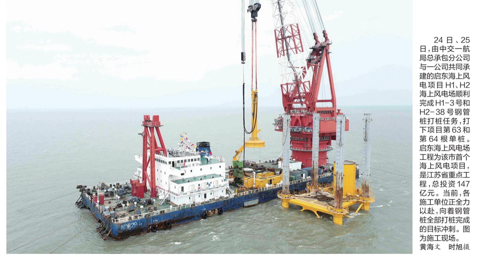
24日、25日,由中交一航局总承包分公司与一公司共同承建的启东海上风电项目H1、H2海上风电场顺利完成H1-3号和H2-38号钢管桩打桩任务,打下项目第63和第64根单桩。启东海上风电场工程为该市首个海上风电项目,是江苏省重点工程,总投资147亿元。当前,各施工单位正全力以赴,向着钢管桩全部打桩完成的目标冲刺。图为施工现场。
