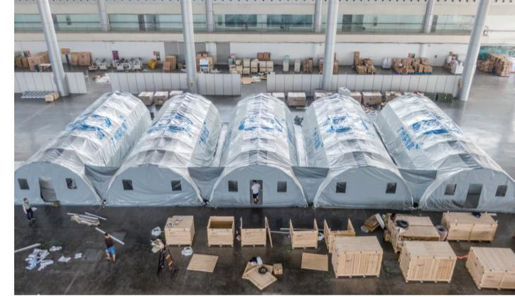
昨日在扬州国际展览中心拍摄的搭建中的“猎鹰号”硬气膜实验室。全部投入使用后,将用于大规模核酸样本的检测与筛查。每日可检测15万管,如果按照10:1的混检比例,每日可筛查150万人次。
