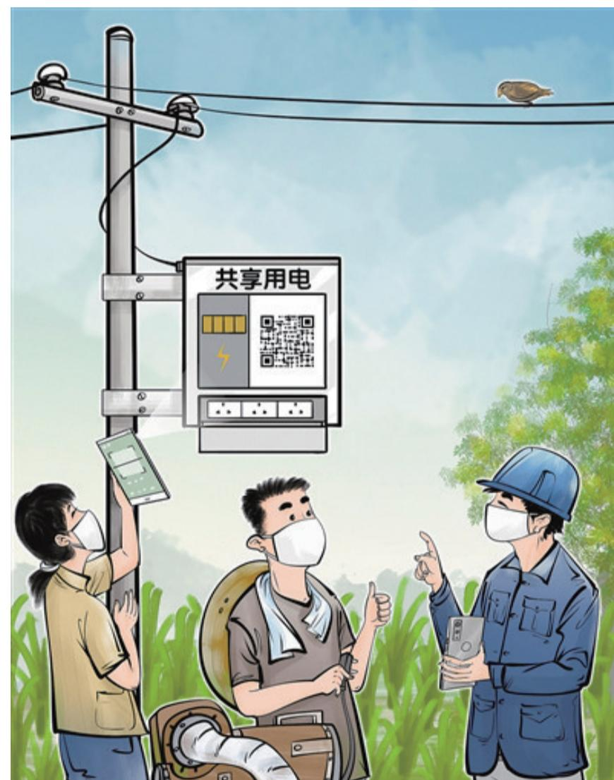
通过具有扫码刷卡一体化、一表共用、电费实时结算、自动缴费等功能的智能扫码共享用电终端,农户只需打开手机扫描二维码,即可终端用电、灌溉农田,还能实时掌握用电情况。前不久,安徽省铜陵市开展农业“共享用电”试点,为生产提供便利。
