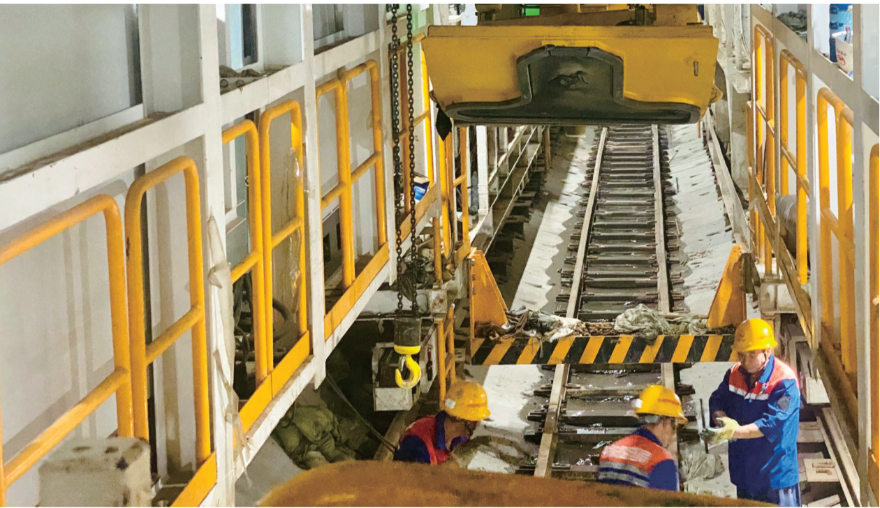
▲昨天，盾构机已经掘进到243环(一环1.5米)，工人们正在安装轨道。 记者 彭军君摄
