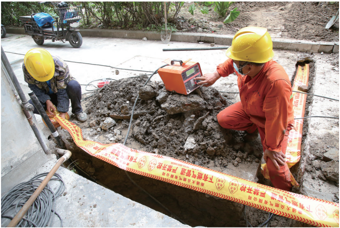
昨天,市区和平桥街道老小区濠西园内,施工人员正在将铁燃气管道全部更换为新型PE燃气管道,保障居民用气安全。 李斌摄
