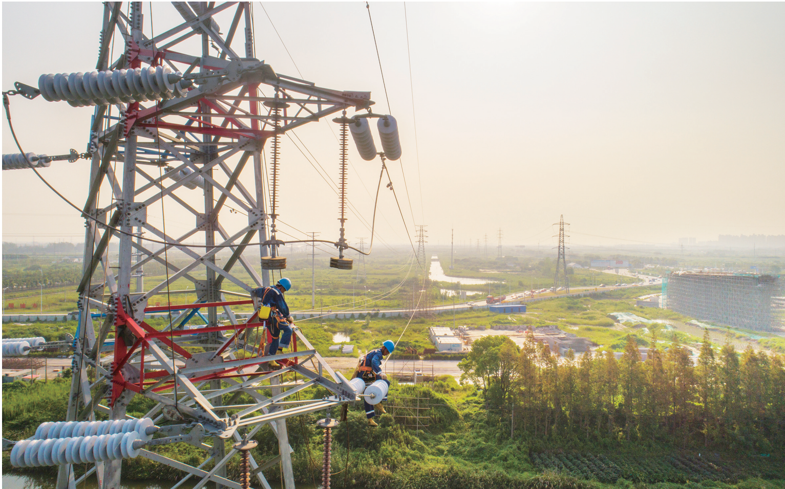
9月1日,国网南通海门供电公司施工人员在建设中的城市外环高架快速通道附近的110千伏常牵线电缆改造施工,切断高架上空的跨越导线,改由埋地顶管电缆穿越,1400米高压电缆穿越水塘河堤复杂区域,工人们在36℃高温下挥汗如雨。黄海摄
