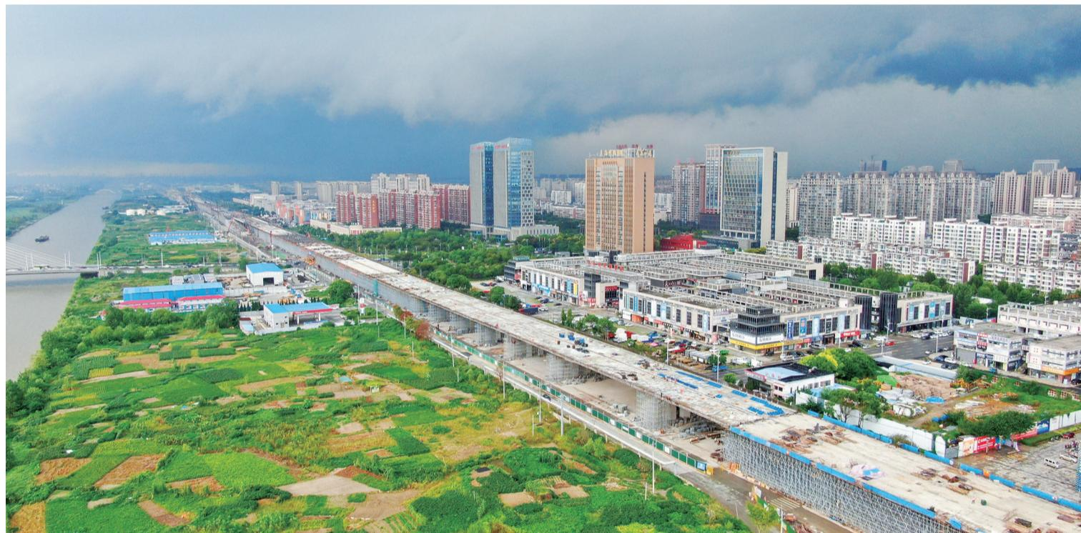
9日在江海大道东延工程第七标段拍摄的画面,七标段现浇箱梁全线贯通。据了解,近几日,江海大道东延工程七标段等三四个标段箱梁全部贯通,目前各个标段施工稳步推进。
