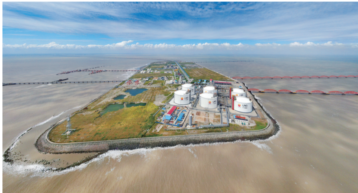
9月16日在如东县洋口港中石油江苏LNG接收站拍摄的三期储罐新貌。2018年11月,中石油江苏LNG接收站扩建(三期)工程开工建设,建设两座20万立方米的LNG储罐,目前三期储罐即将投产,将为冬季保供增添新保障。 记者 许丛军摄
