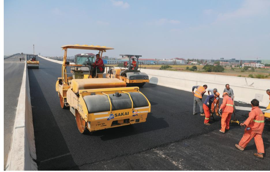
昨天,我市重点城建工程江海大道东延工程高架主线实现全程贯通。目前施工方正在进行沥青摊铺和伸缩缝的施工安装工作。
