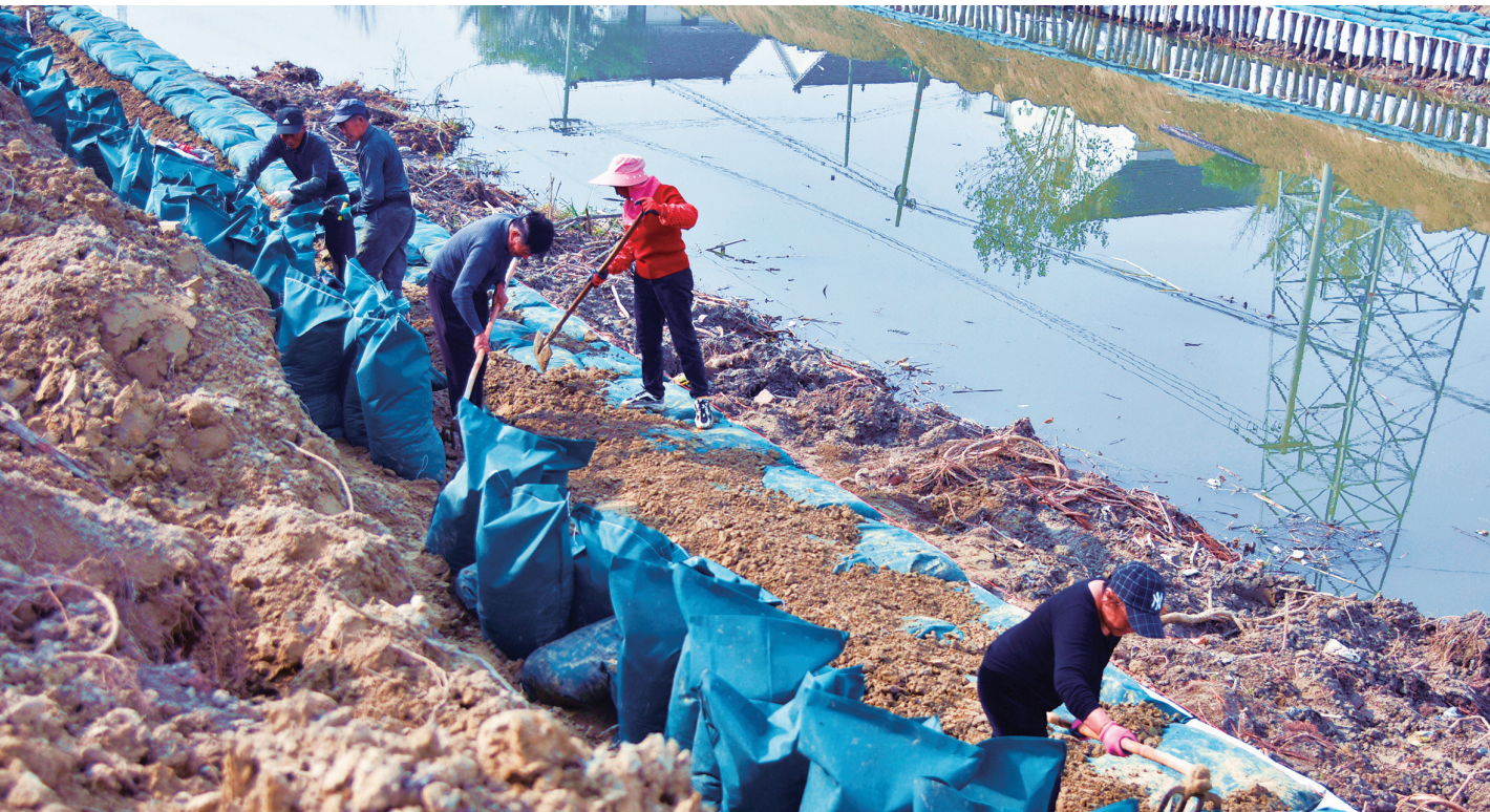
16日,如皋市如城街道姜桥港生态修复工程施工现场,村民正在垒砌生态袋。如皋市水务部门积极抓住有利时机,组织施工队伍整治河道,加强水毁工程维修,新建水闸,加快农村水利建设,掀起新一轮的秋冬水利建设热潮。 CFP供图
