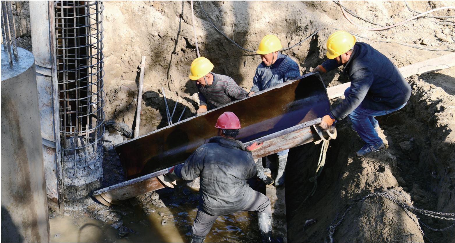
23日,施工队正在海安高新区青萍港村加紧修建节水暗渠。 海安市抓住冬修水利的黄金季节,集中机械和人力抢抓工期,推进高标准农田建设,让群众享受到水利发展带来的实惠,为保障粮食安全生产和推进乡村振兴夯实基础。 顾华夏 丁慧摄
