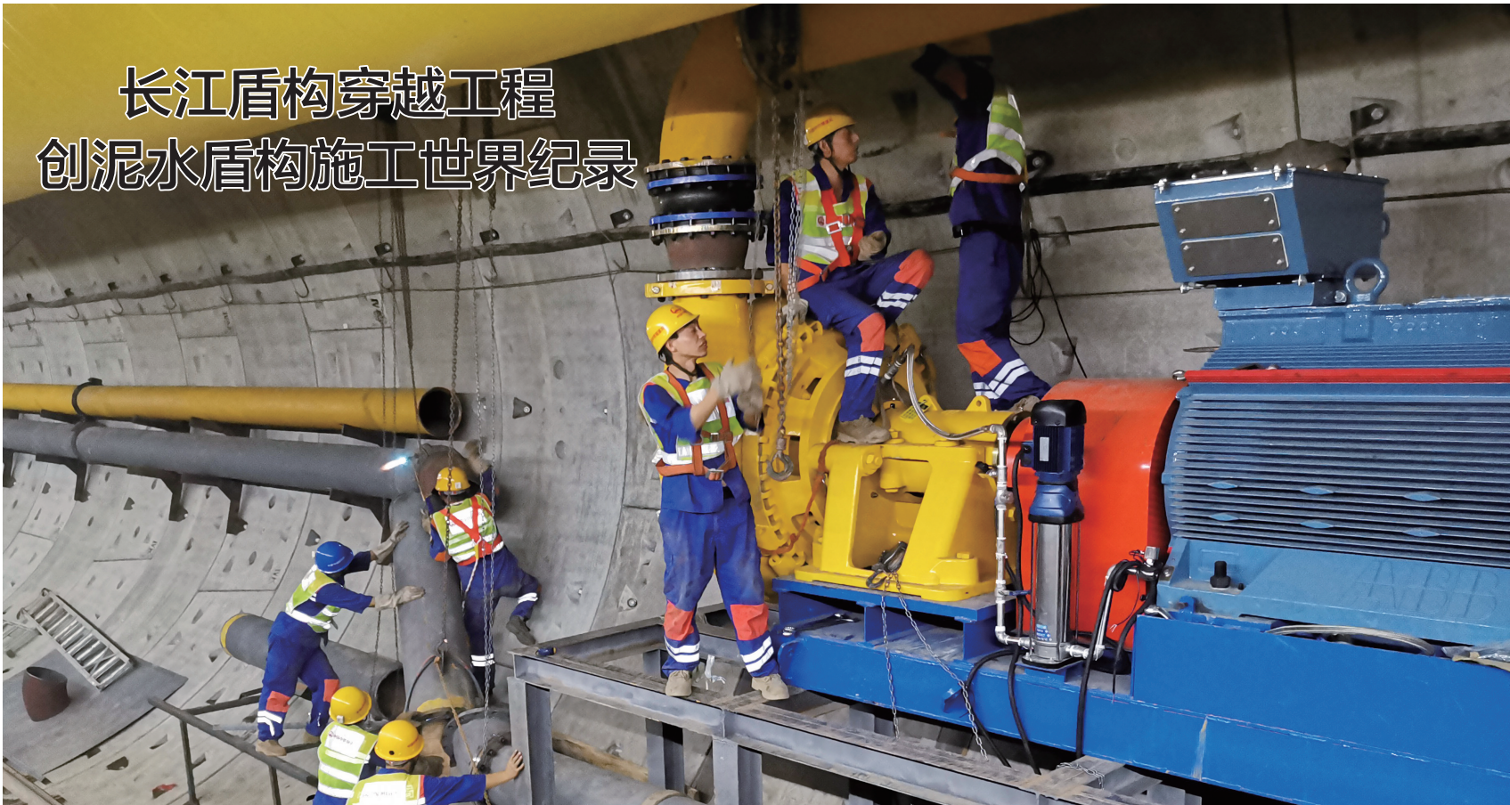
一个月，669环，1003.5米！昨日，位于海门经济技术开发区的中俄东线长江盾构穿越工程现场再传捷报：根据工程调度统计，由国家管网集团、江苏省沿海输气管道公司建设，中铁隧道局施工的中俄东线天然气管道长江盾构穿越工程“畅通号”盾构机在11月份累计掘进1003.5米，创造了泥水盾构机单月掘进世界最快纪录。上图：施工人员进行隧道泵站安装。 彭军君文 中铁隧道局供图
