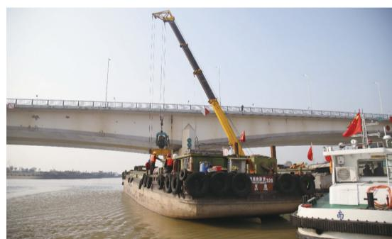
本报讯 (通讯员李映晓 记者蒋娇娇)7日,滨江大桥下的航道内,三艘作业船正进行着防撞墩沉桩作业(上图,李映晓摄)。随着振动锤开启,一根根钢管被“钉进”河床,成为守卫桥梁安全的又一道“铜墙铁壁”。当前,由市政部门组织实施的船舶碰撞桥梁隐患专项整治行动已进入施工阶段,计划对21座内河通航桥梁进行集中整治,提升桥梁防撞能力和航道通航保障服务水平。
