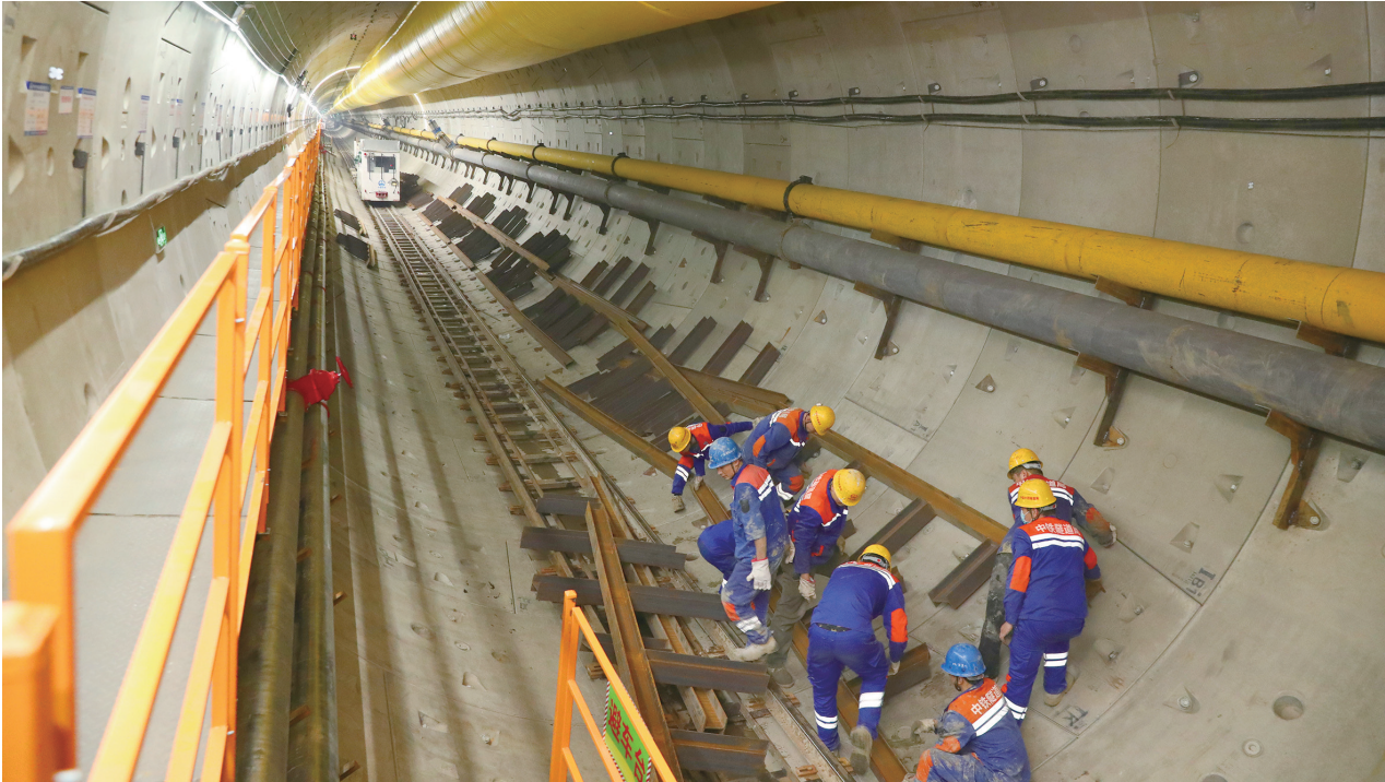
7日，施工人员在“万里长江第一长隧”的长江盾构穿越工程现场安装施工道岔。 “万里长江第一长隧”——中俄东线天然气管道长江盾构穿越工程有序推进。该工程是国家能源大动脉中俄东线的“咽喉”项目，是目前世界油气领域单向盾构掘进距离最长、埋深最深、水压最高、口径最大、施工环境最复杂的油气管道穿江盾构工程。 记者 许丛军摄
