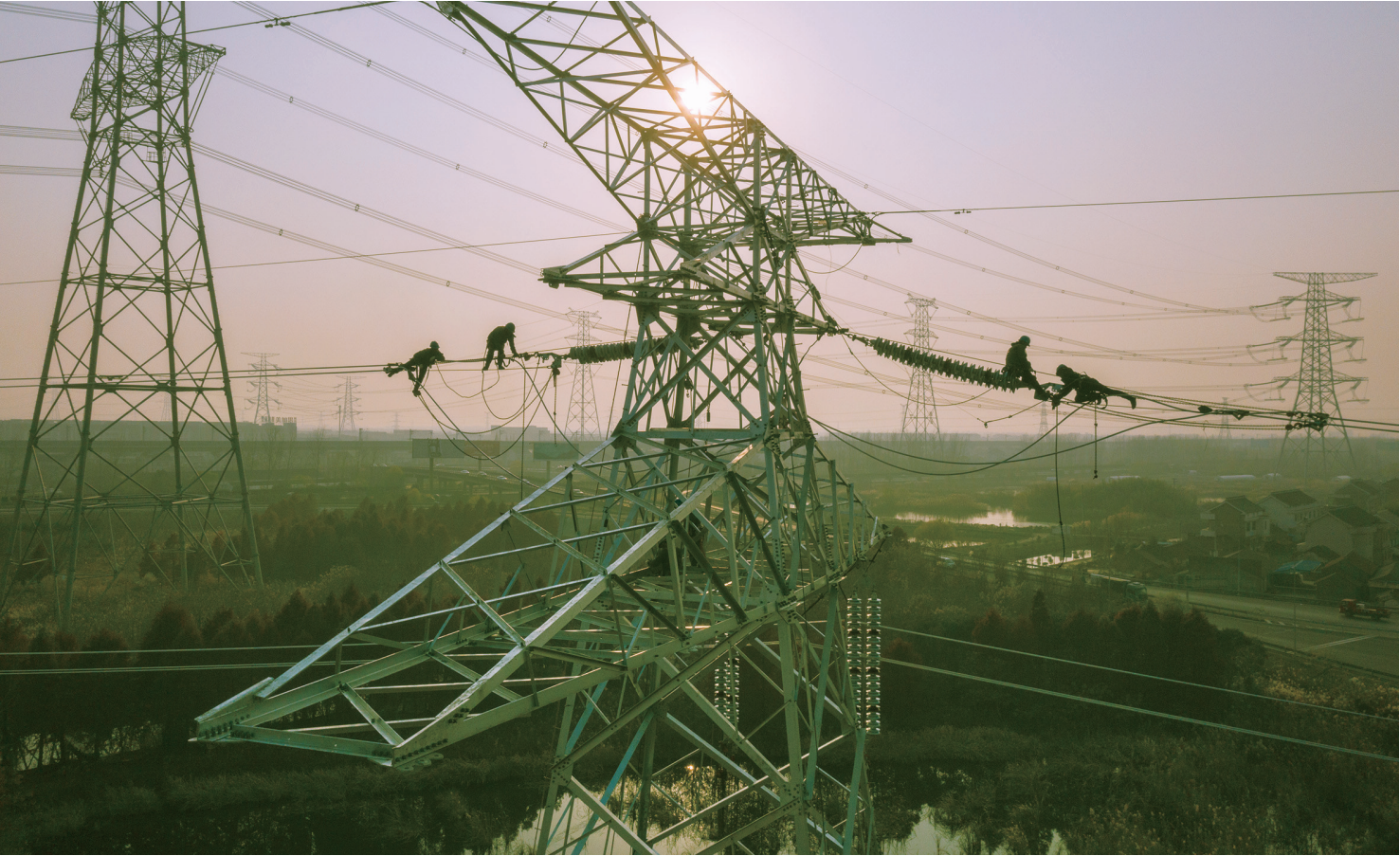
11日，220千伏常海线铁塔升高改造正在收尾。经过五昼夜紧张施工，海门叠港公路沿线疏港铁路一期工程，正在建设施工的单线T梁主墩走向和输电线路交叉点通道实现贯通。110千伏海彦线/海英线改由入地电缆穿越疏港铁路通道。 通讯员 黄海摄
