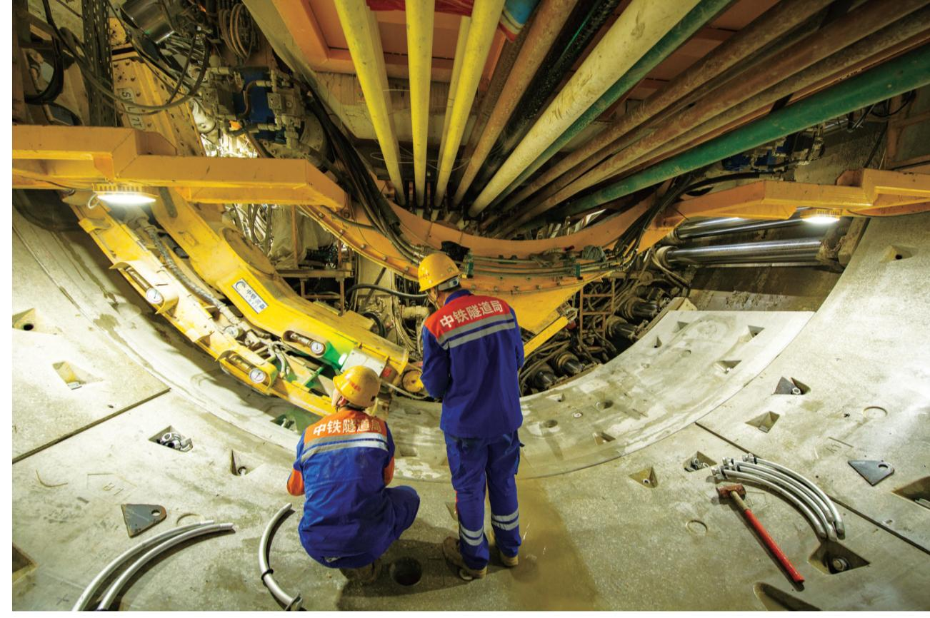
19日,中俄东线天然气管道(永清-上海)长江盾构穿越工程“畅通号”盾构机掘进突破2000环,隧道成洞里程3000米。技术人员在隧道内检测评估设备运行状态,确保掘进顺利进行。长江盾构穿越工程是中俄天然气东线全线的控制性工程,全长10.226公里,工程建成后,可把途经东北三省、京津冀地区的“俄气”送至长三角地区,提高长三角地区天然气管网的应急保障能力,满足地区天然气产业发展需要和民生用气需求,有效改善长三角地区的大气环境。
