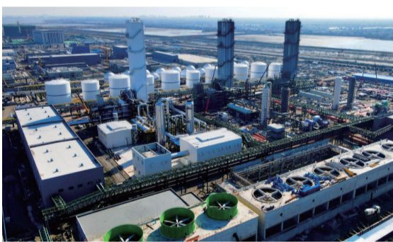
中天绿色精品钢项目制氧单元正在安装设备
