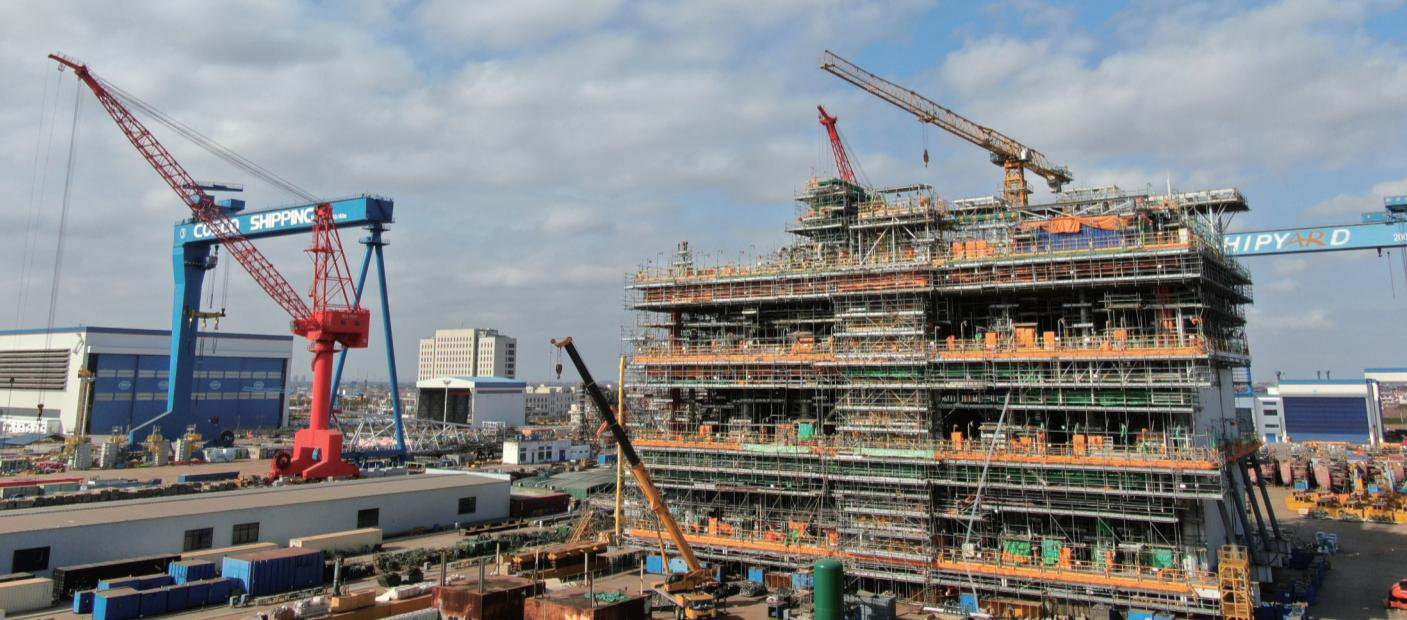
21日，在启东海工船舶工业园的启东中远海运工厂区，俄罗斯北极2液化天然气项目第2条生产线工艺模块正在加紧建造。长64米、宽38米、高48米的模块犹如一幢高楼，每一层都有工人在各自岗位忙碌。据介绍，目前每天有800人出勤北极2项目，春节期间将有约300人留守继续进行建造作业。
