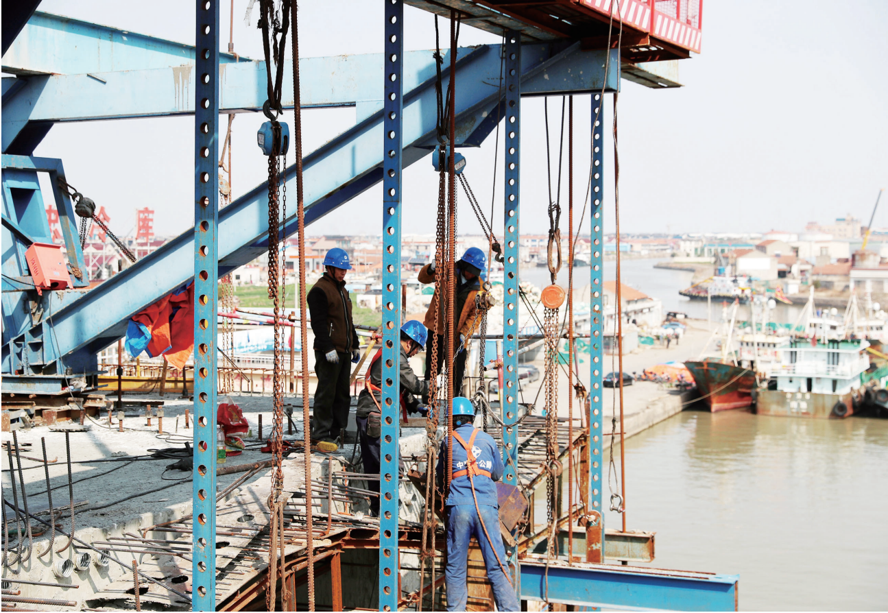
3月2日,鹤港大桥建设现场,数十名工人正在进行桥梁上部结构施工。鹤港大桥由南通路桥工程有限公司承建,横跨三级航道大洋港,桥宽25米,主跨长120米,跨径为启东市交通建桥工程史上之最。目前主桥已完成65%,引桥已完成90%。预计今年6月完成主跨合龙,9月完工通车。 记者 尤炼摄
