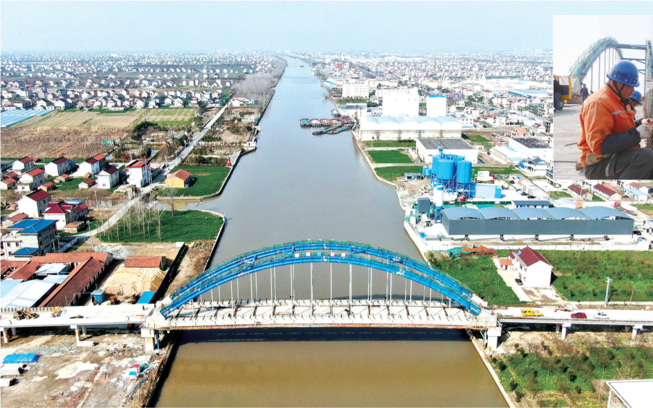
3月2日拍摄的建设中的启东天汾大桥。天汾大桥老桥始建于1969年，去年3月，老桥拆除改建。新建的天汾大桥位于老桥上游104米处，总长341.32米，总跨度335米，主跨达95米，为启东首座下承式钢管混凝土系杆拱桥。目前工程已完成90%，4月底将完工通车。
