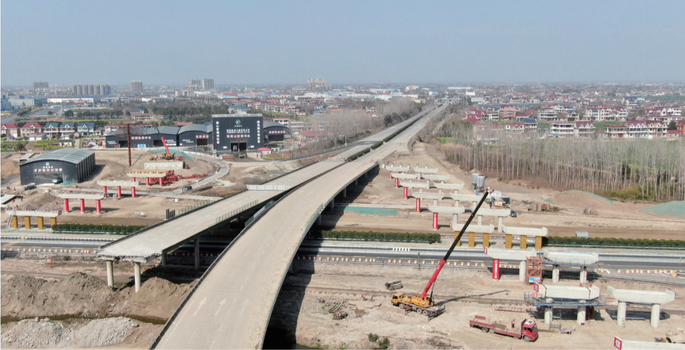
9日拍摄的沪陕高速平潮至广陵段扩建工程施工场景。该工程由平湖北枢纽起至如皋市九华镇,全长6.86公里,全线采用双向八车道高速公路标准扩建,设计速度120km/h,路基宽度42米。该项目于去年11月完成半幅封闭,半幅借道单向通行的交通导改,全面开展沪陕高速平潮至广陵段的拼宽施工。截至目前,工程进展顺利,已完成40%。记者 尤炼摄
