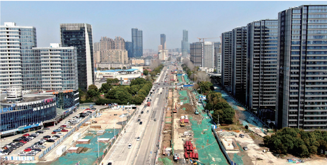
24日,施工人员在工农路实施雨污水管道铺设,工农路改造二期北段工程进展顺利。工农路改造项目北起江海大道,南至菡园路,全长约9公里。围绕城市更新理念,主要实施道路改造、景观提升、城市家具、多杆合一、智能交通及配套等内容,机动车道由原双向六车道优化为双向八车道。
