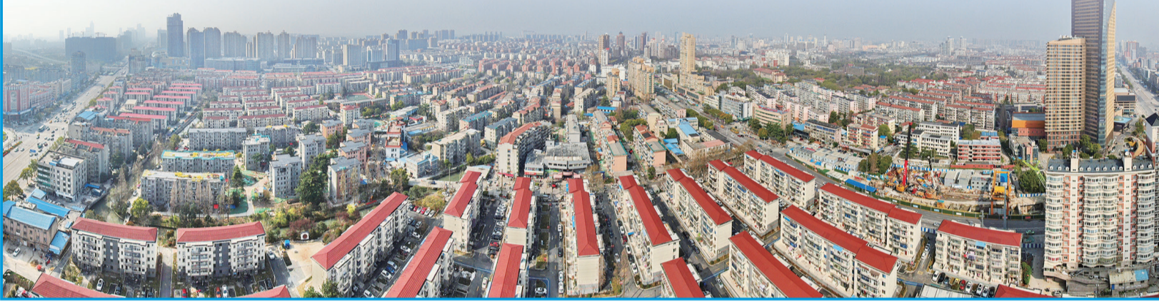
崇川区新城桥街道易家桥新村老旧小区改造现场。 记者 许从军摄
