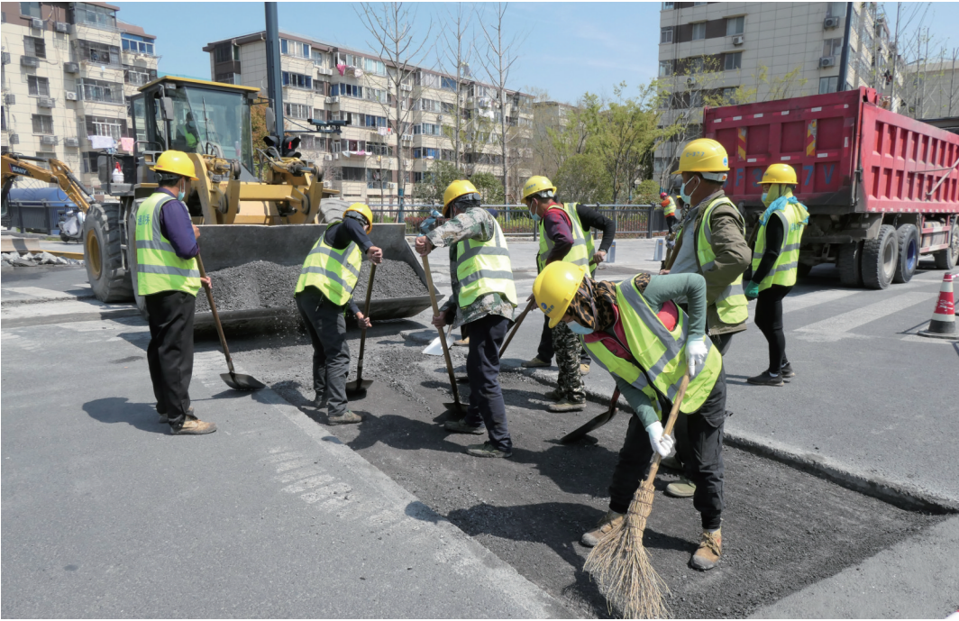
日前,记者在虹桥路综合提升改造工程项目现场看到,工人正在对沥青面层进行铣刨加铺施工,以减小交叉口施工对交通通行的影响。据安排,近期开始进行沥青上面层的摊铺,5月底虹桥路将全线竣工。
