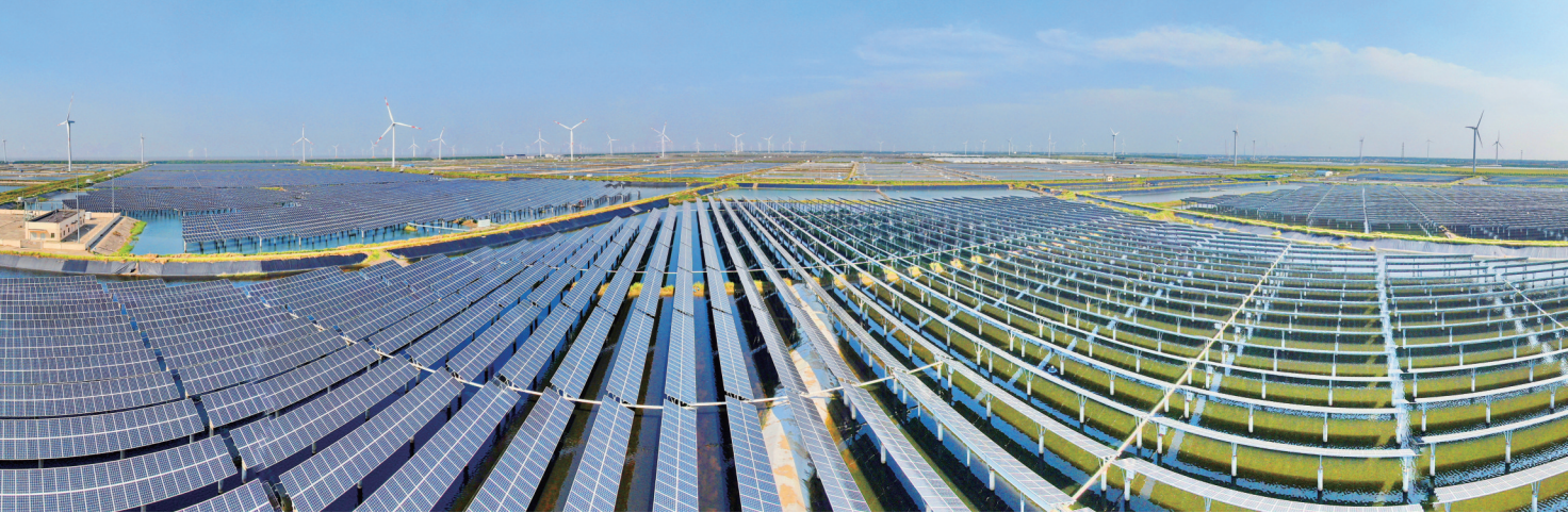
2日拍摄的如东通威“渔光一体”互补项目一角。该项目是全国首个渔光互补项目,上产出清洁能源,下产出绿色健康水产品,实现了资源的高效综合利用。 今年一季度,如东县以通威“渔光一体”互补项目为代表的一批光伏发电项目累计上网电量5300万千瓦时。 记者 许丛军摄
