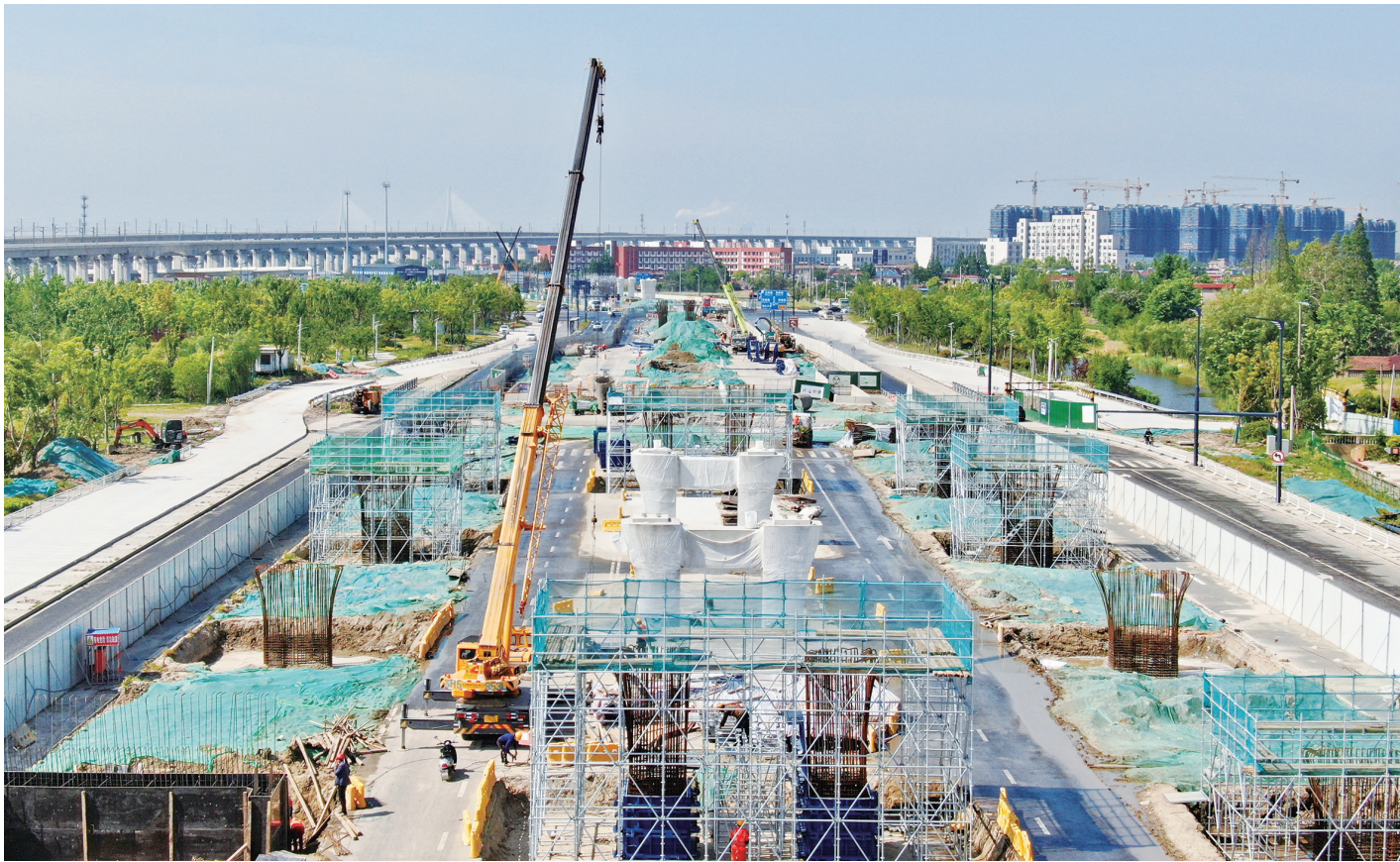
8日拍摄的南通西站大道（二期）工程忙碌的施工现场。西站大道是南通市规划快速路网的重要组成部分。作为“承上启下”的城市交通动脉、南通对外城市形象展示的重要门户道路，西站大道既是通州区连接南通城区及如皋市区的快速路，又是完善西站枢纽集疏运功能的区域快速通道。 西站大道（二期）工程位于通州区，南起长江路西延，北至港平路，路线全长6420米，全线采用高架快速路形式。主要建设内容为道路、桥梁、排水、绿化、交通设施、管线综合及其他配套设施等。 记者 许丛军摄
