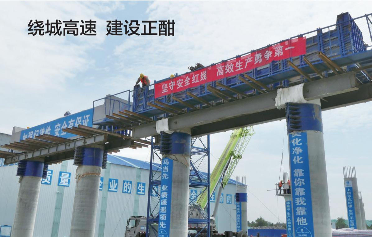
昨日,南通绕城高速公路项目新联枢纽建设现场,施工人员奋战在各自作业面上。截至目前,南通绕城高速公路项目新联枢纽381根立柱完成近80%、151个盖梁正在加紧施工,计划于明日进入G15沈海高速,从桩基开始进行第一步的基础施工。记者 黄哲摄
