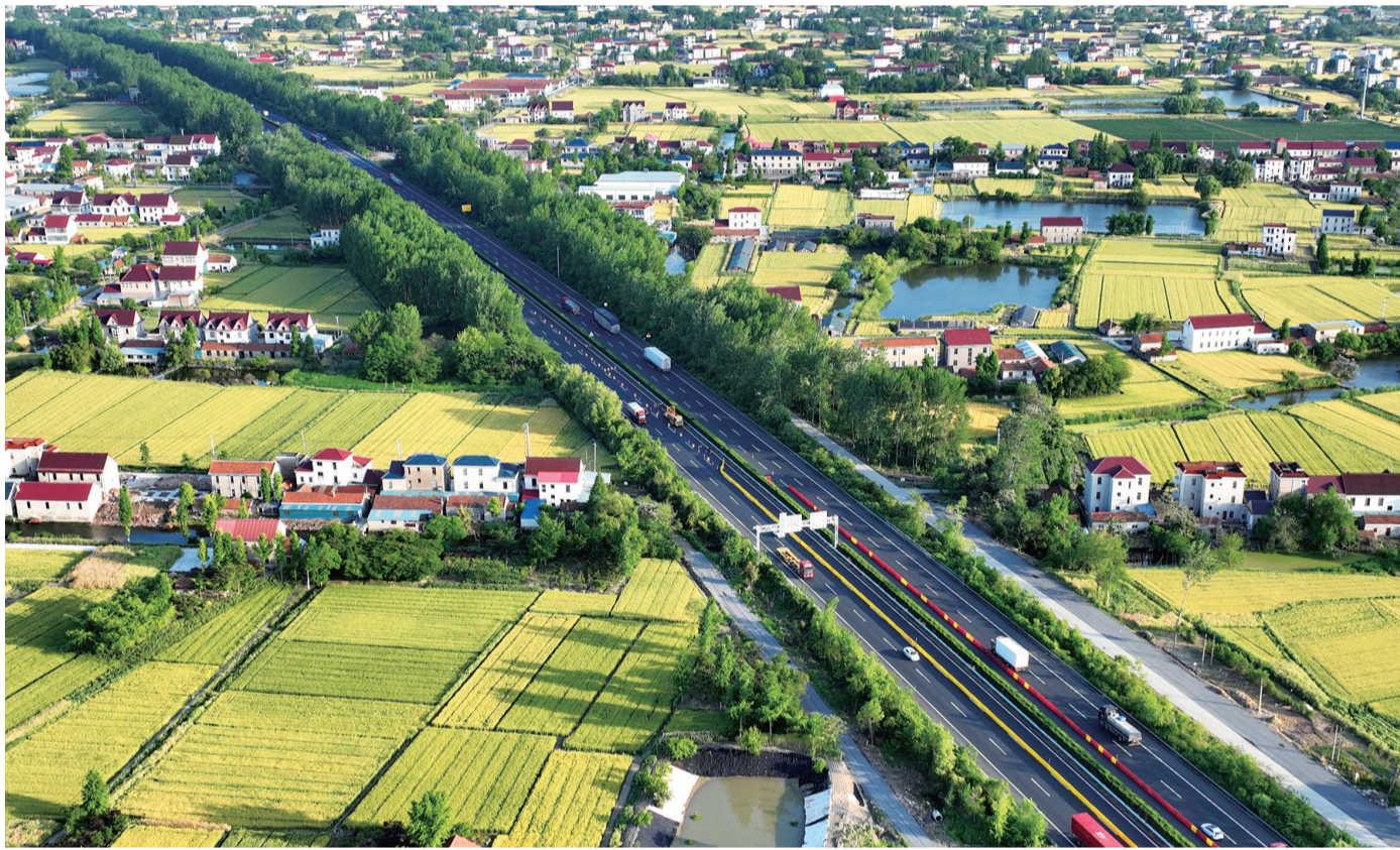
13日,无人机航拍G15沈海高速美丽景色。在南通到如皋的高速公路路段两侧,绿树、麦田、民居等为这一段路增添了多种颜色,俯瞰高速公路,宛如一道靓丽的风景线。 记者 许丛军摄
