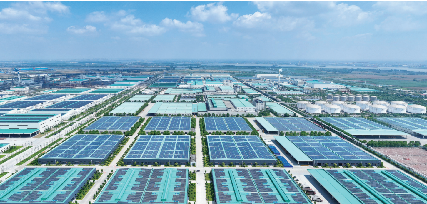
7日在通州区五接镇拍摄的恒力(南通)产业园屋顶分布式光伏发电项目一角。近年来,恒力(南通)产业园将屋顶光伏发电项目作为推动能源绿色低碳转型的重要举措,截至目前,四期光伏项目全部投运,全年发电量达5500万度,成为江苏省最大的企业分布式光伏发电项目。 记者 许丛军摄
