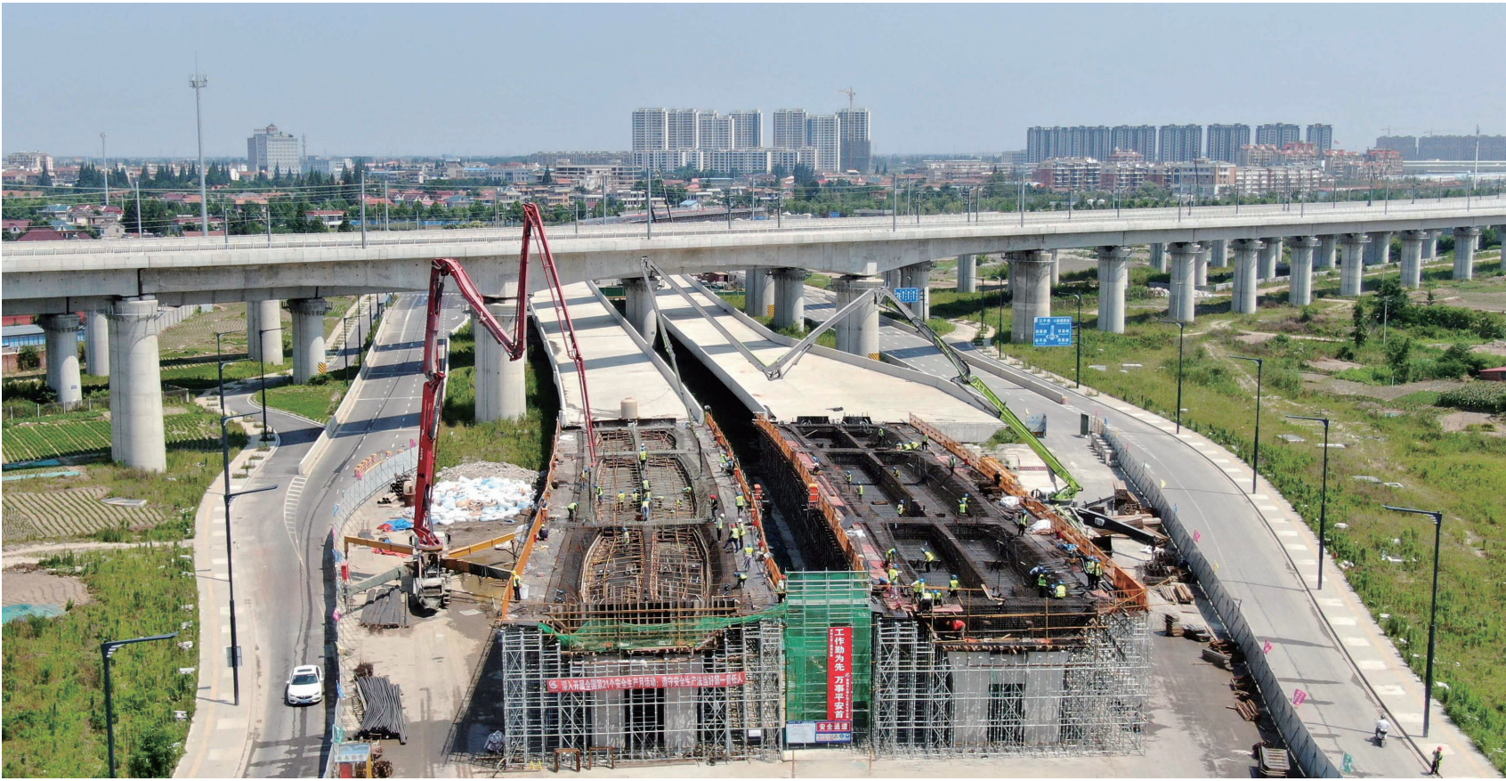
昨日，西站大道(二期)工程首件箱梁混凝土成功浇筑。该工程位于通州区平潮镇，是市区快速路网的重要组成部分，共分为五个标段，目前各标段正全力以赴推进相关工作。截至目前，全线已完成灌注桩1344根，占总量的84.8%、承台201座，占总量的65.5%、墩柱165座，占总量的51.6%。 记者 尤 炼摄
