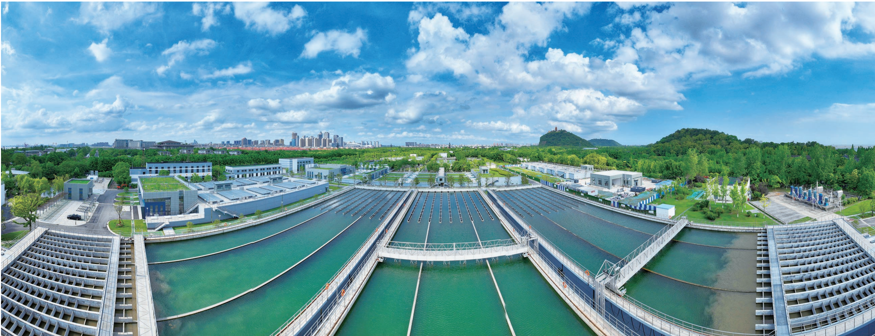
7月2日航拍的狼山水厂一角。狼山水厂全年制水量已达1.5亿立方米。服务人口约百万的狼山水厂主要满足南通主城区用水需求，服务范围包括崇川区、开发区、通州区平潮镇和五接镇，制水工艺采用常规处理与深度处理、超滤膜相结合。
