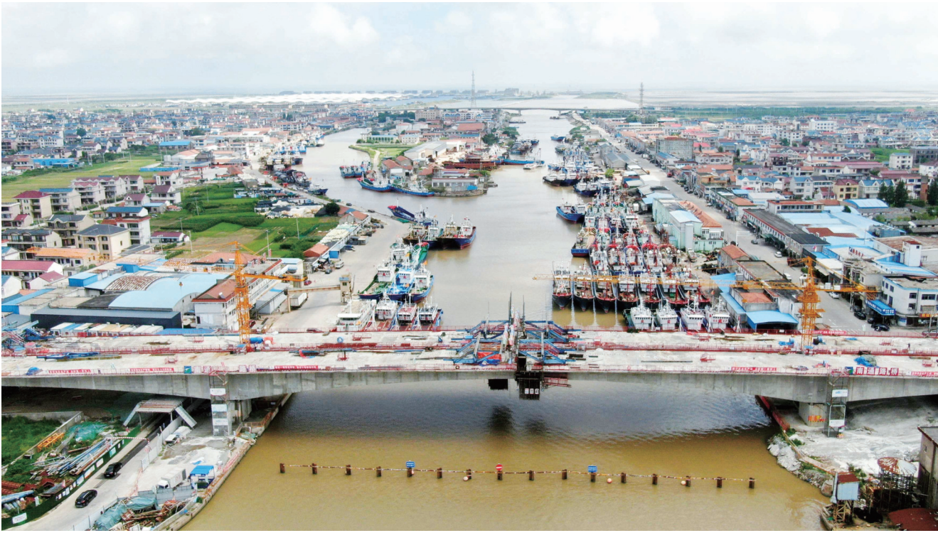
7月5日，航拍鹤港大桥建设现场。鹤港大桥位于启东市吕四港镇，目前主桥施工已完成接近90%，悬浇节段已全部完成，进入到合龙阶段。预计本月底主跨合龙、9月底大桥建成通车。 记者 尤炼摄
