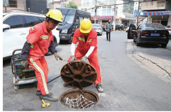
昨日,在和平桥街道起凤社区起凤园小区,市政工人对加装安全防坠网的窨井盖上井盖。给排水窨井加装安全防坠网,可以在井盖破损时防止人、重物掉落,起到保护居民出行安全的作用。
