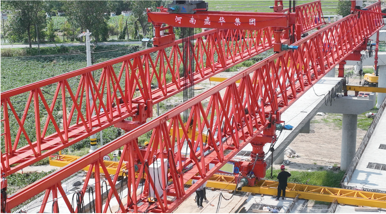
18日拍摄的洋通高速二期工程掘坎河大桥架梁现场。目前,洋通高速二期全线首座板梁桥北垦南横河中桥所有板梁全部架设完成,掘坎河大桥架设到第十跨,预计年内将完成90%桥梁上部结构施工。
